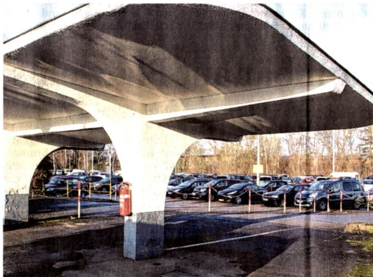
Hier auf dem Reflex-Gelände an der Veldener Straße soll die neue Hauptfeuerwache der Stadt Düren gebaut werden. Der Standort wäre zentraler, die Wehr könnte bei Einsätzen schneller vor Ort sein. Foto: bugi
